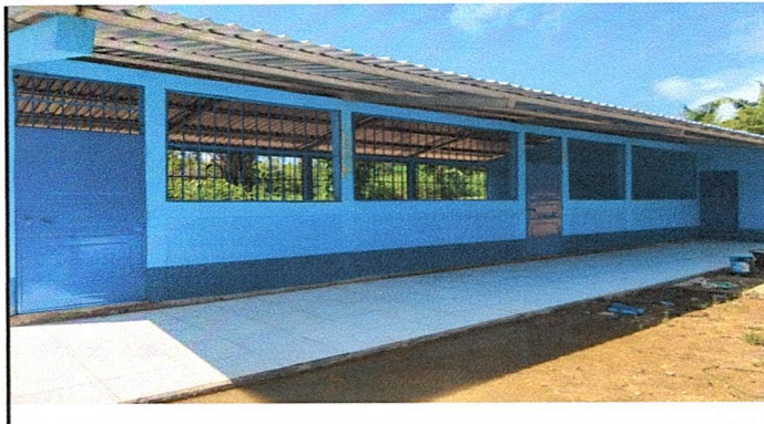
FOTOGRAFIA 2: Instalación de las puertas y ventanas.
