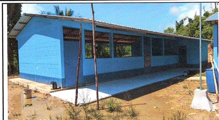
FOTOGRAFIA 1: Finalización de la colocación de laminas.
