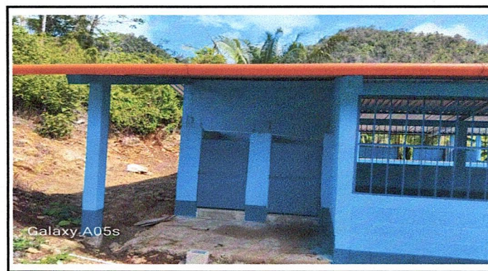
FOTOGRAFIA 6: Vista de la puerta de los baños finalizados.
