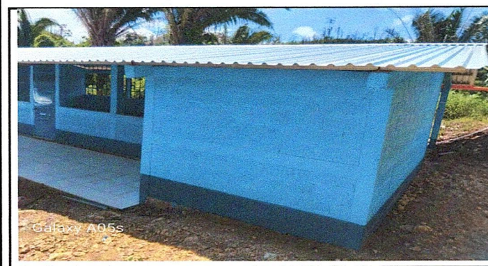
FOTOGRAFIA 5: Observa los trabajos finalizados de la direccion.
